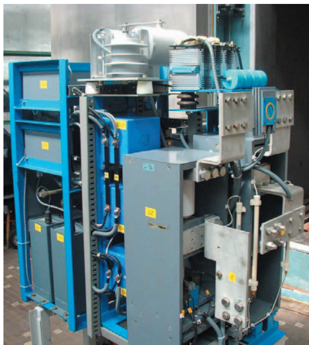
Fot. 1. Próżniowy wyłącznik szybki prądu stałego typu DCN
