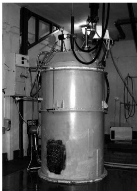
Rys. 4. Widok pieca do witrifikacji odpadów (Katedra Aparatów Elektrycznych PŁ)
